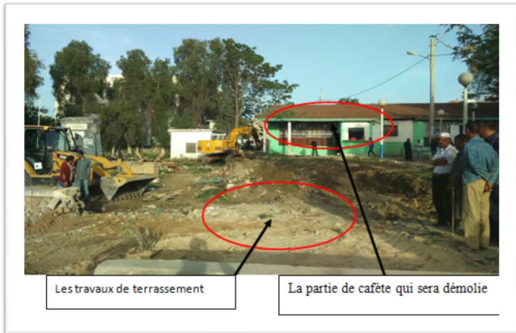
Figure32 :les travaux de la vois concernée
