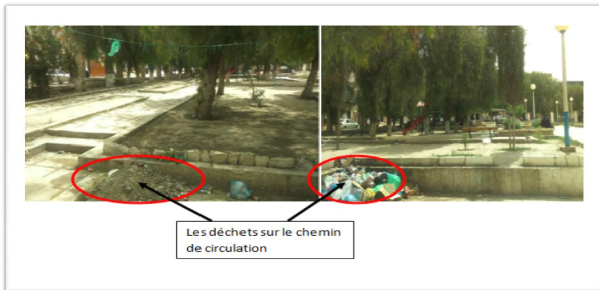
Figure 24 :l'état de chemin de circulation, la bordure, et les ordures tombants.
