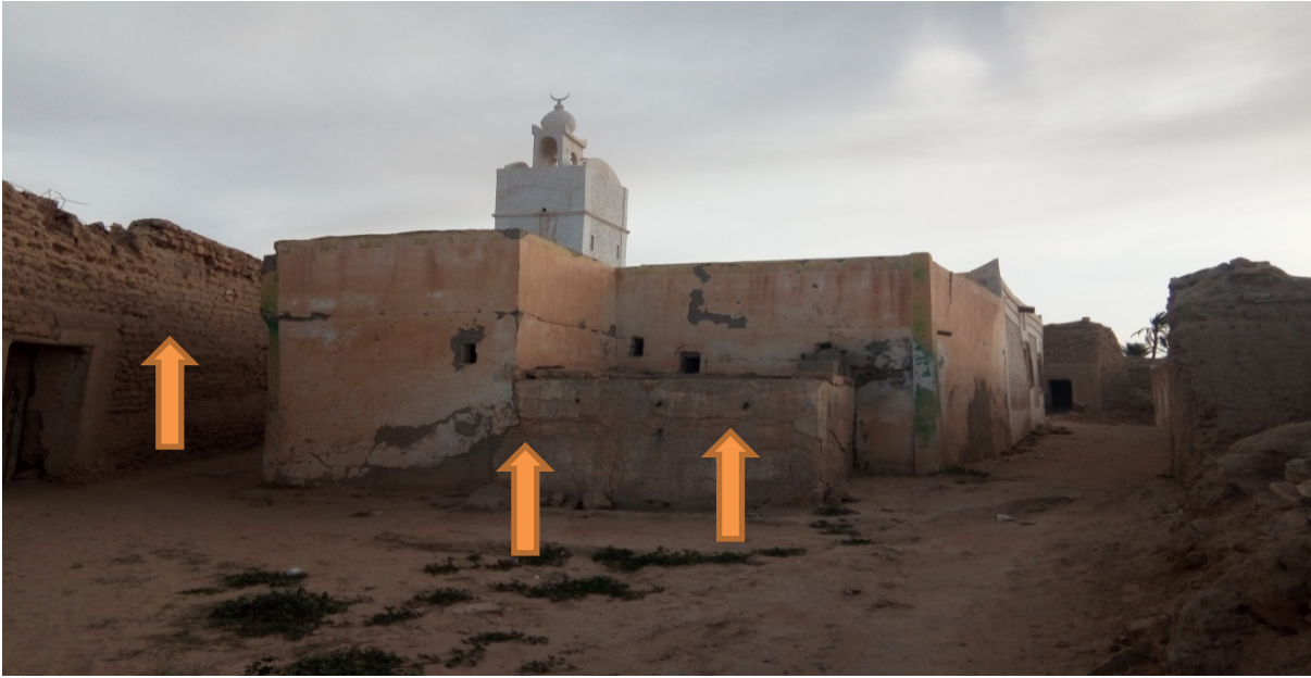
صورة رقم-54-:انفصال طبقة الكساء الخارجية عن الجدران
