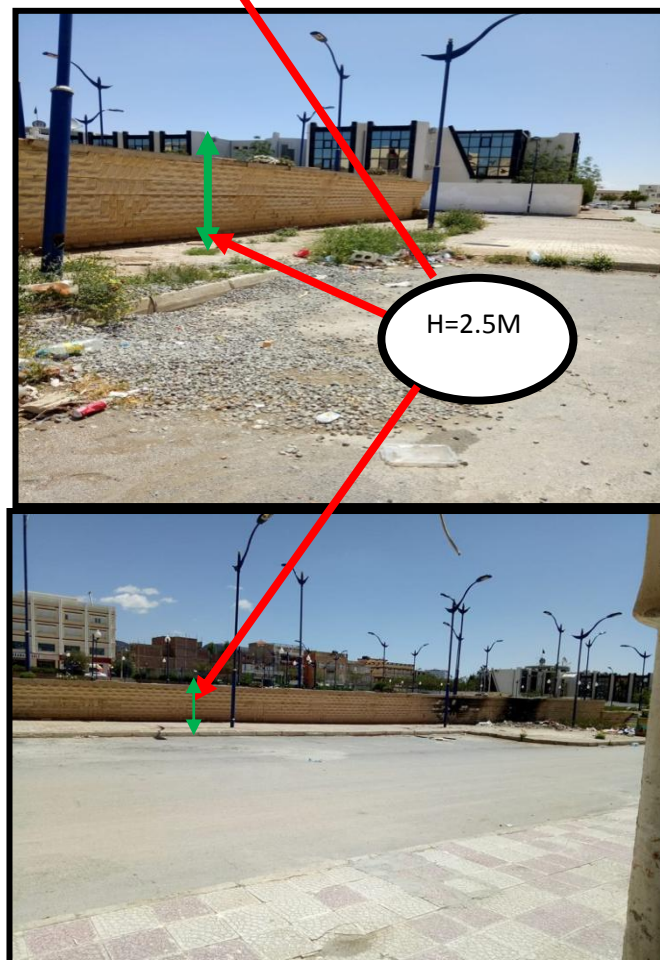
Figure n°47 : photographie montre la hauteur de la place de cote sud ( Etablie par l'auteur le 02 /05/2018)
