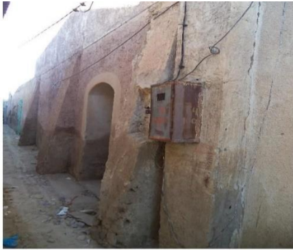
(photo29) Daama soutenant le mur d'une maison source :PPSMVSS d'El Acheche-Messaaba
