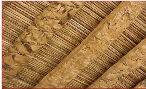
(photo24) l'utilisation du bois de palmier dans les plafonds Source : le PPSMVSS du quartier El Acheche-Messaaba, phase 2
