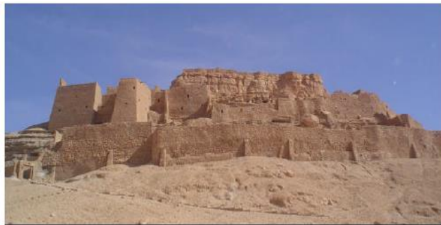
(photo 08) : Le ksar de Goléa, porte un caractère défensif, en pierre avec des formes qui s'intègre sur les différentes lignes de forces de la colline.
