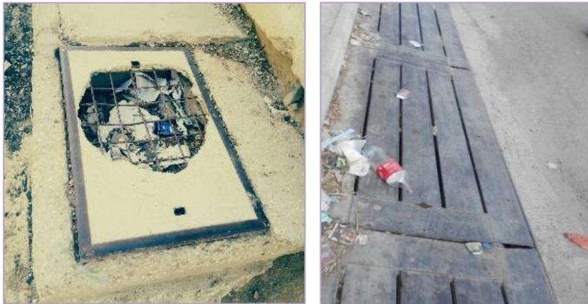
**Photo n°61 :** Les avaloires sans tampons et le réseau d'assainissement vétusté sont exposé à tous les risques de bouchage Cité 134 et 325 logts.
