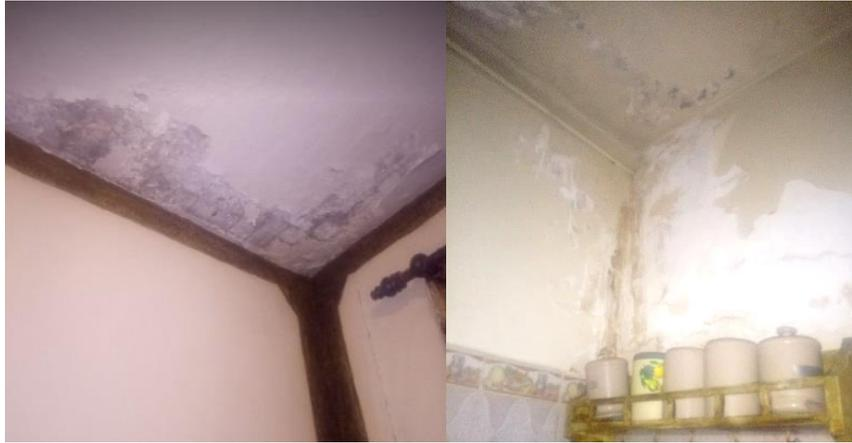
**Photo n°44** : appartement F5 n'a pas subi à aucune modification souffre de problème d'étanchéité, Blocs (B5) cité 134 logts
