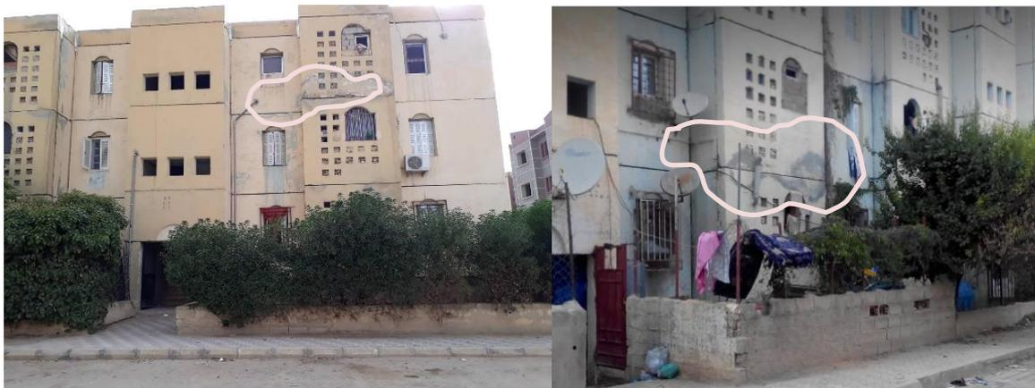
**Photo n°36 :** Traces de fissuration ou d'endommagement causés par l'ancienneté et les interventions multiples des habitants et l'impact négatifs des différentes transformations intérieures sur les façades
