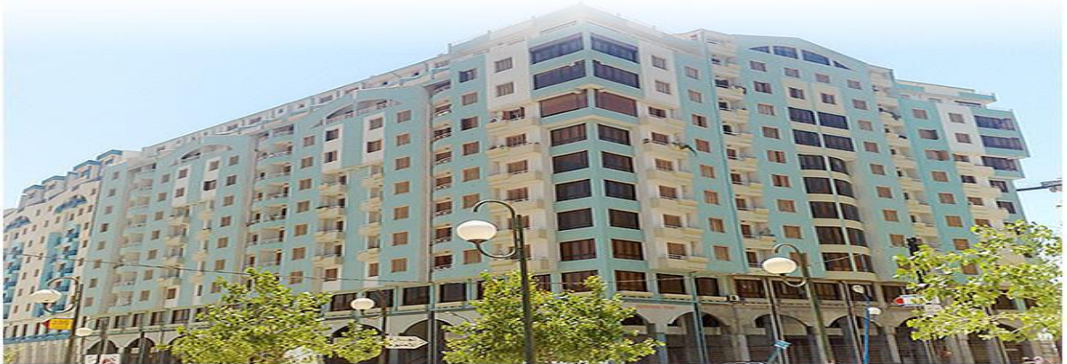
Figure10 : Immeuble promotionnel multifonctionnel (commerces-bureaux-logements) à la ville de Boumerdes Source : http://www.archibest.com
