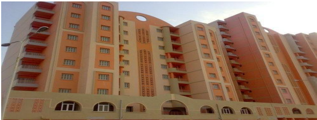
Figure09 : Logements location-vente « A.A.D.L» à la ville de Skikda
