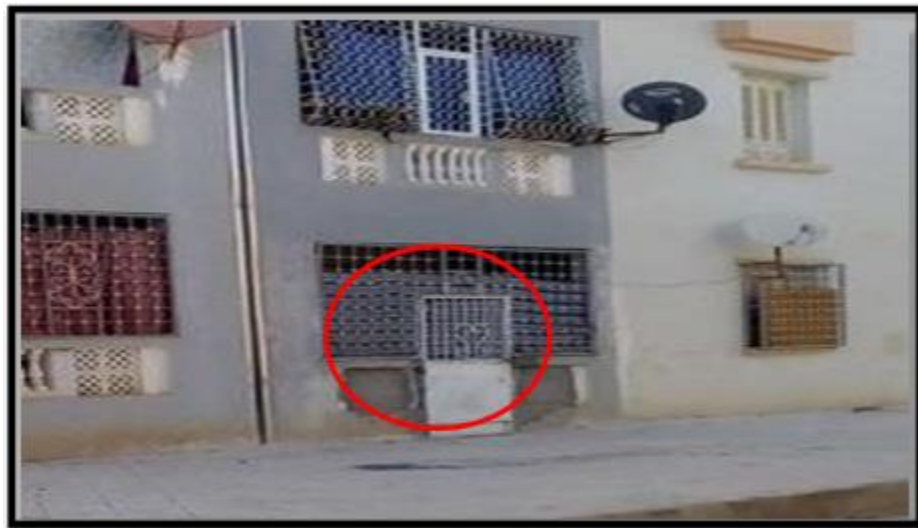
Photo n°06 : Façade après la modification
