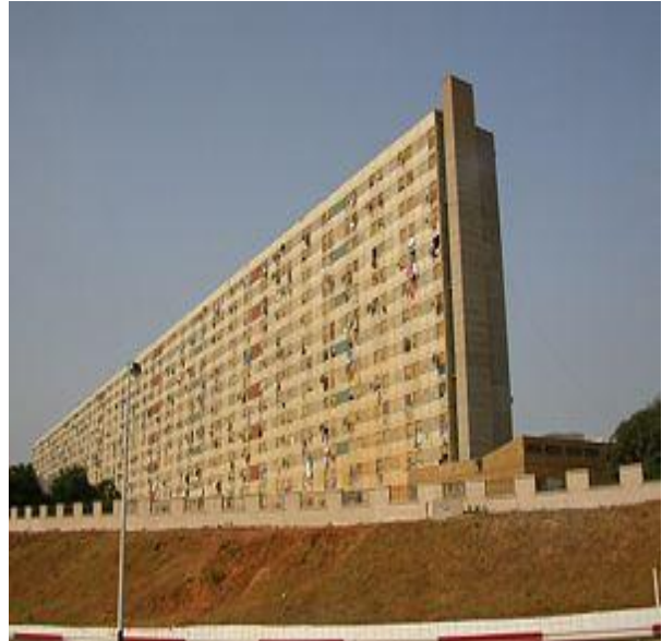
Ensemble d'habitation " les Dun À El Harrach, 1000 logements réalisés en 1959.
