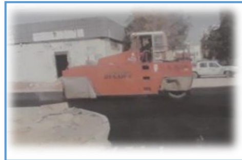
صورة رقم (13): تزويد الطريق بطبقة الخرسانة الإسفلتية
