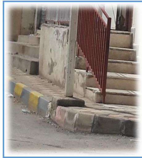
صورة رقم (38) تبين عدم دهن قاعدة العمود
