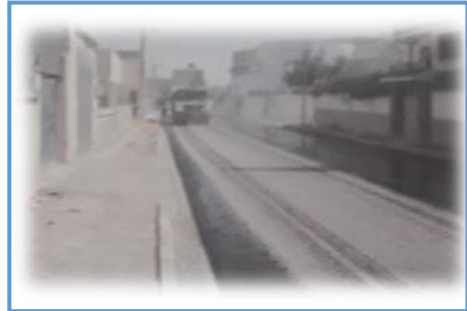
صورة رقم (14): الرش بطبقة الإشراب
