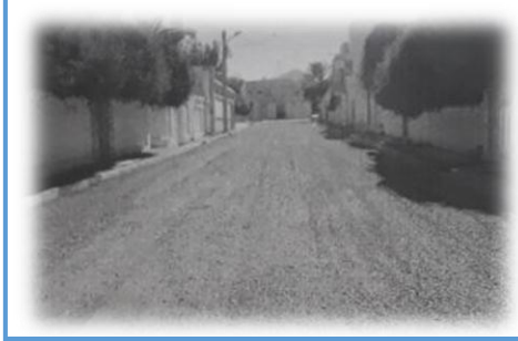
صورة رقم (14): الرش بطبقة الإشراب
