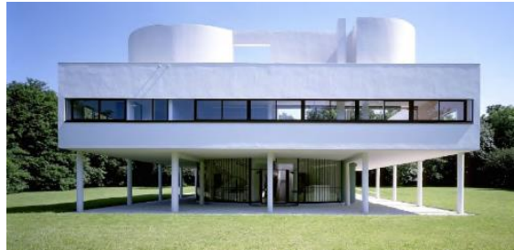
Figure 30 : La fenêtre en bande de la villa Savoye de le Corbusier 1928 à 1931 (Source M. Boudoukh 2015)
