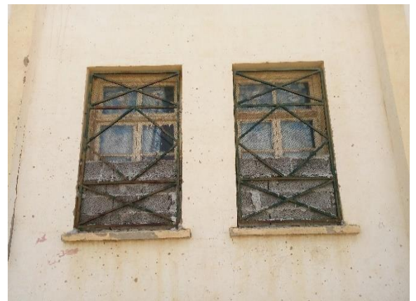
Photo 04 : Façade ouest de l'école
