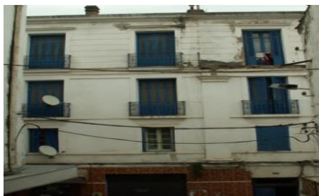
Figure 29 : La fenêtre verticale coloniale dans l'ancienne ville de Bejaia, Algérie (Source M. Boudoukh 2015)
