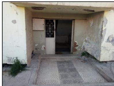
Photo n°30-31 : Dégradation des entrées des blocs
