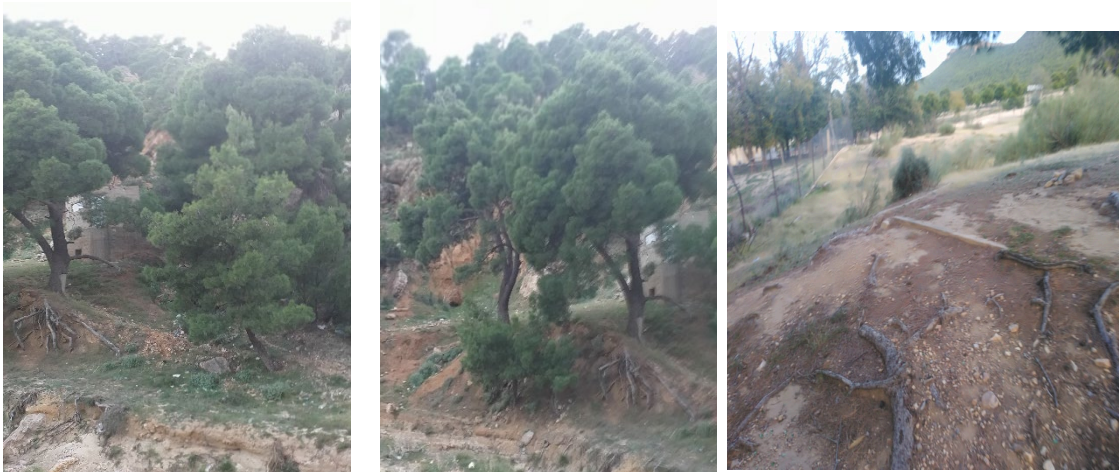
Figure 2.56 : la dégradation du sol d'El-Khanga. Source : auteur.
