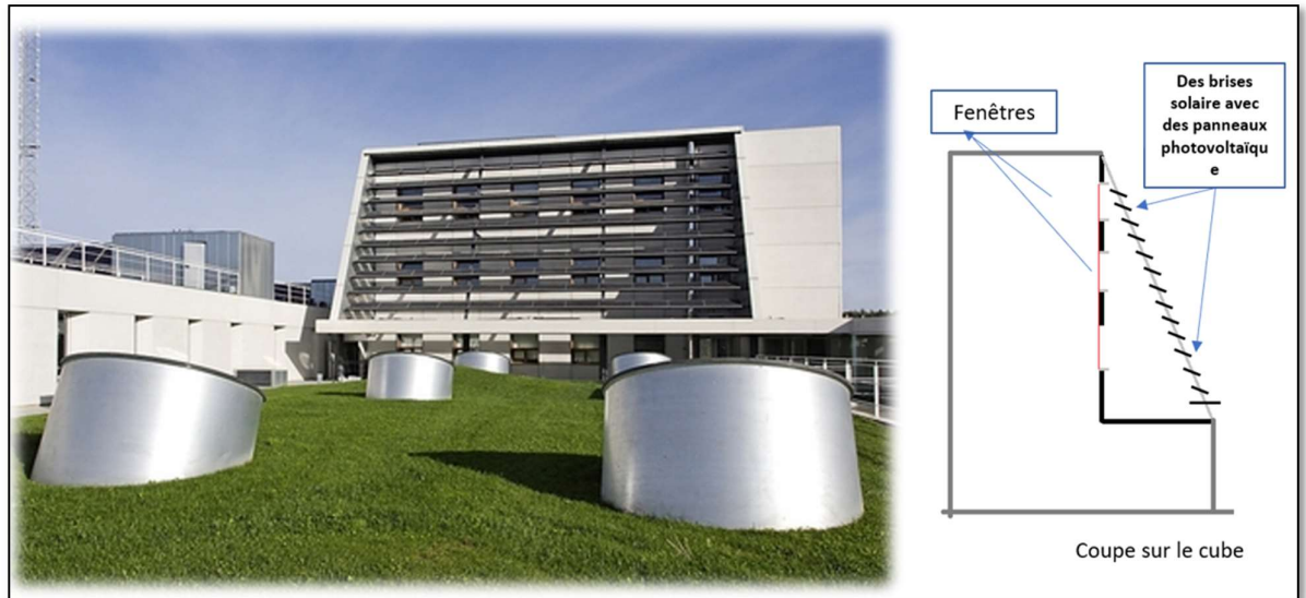
Figure 2- 21: la façade du l'administration
