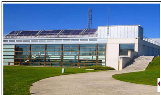
Figure2- 22: façade du bloc administratif
