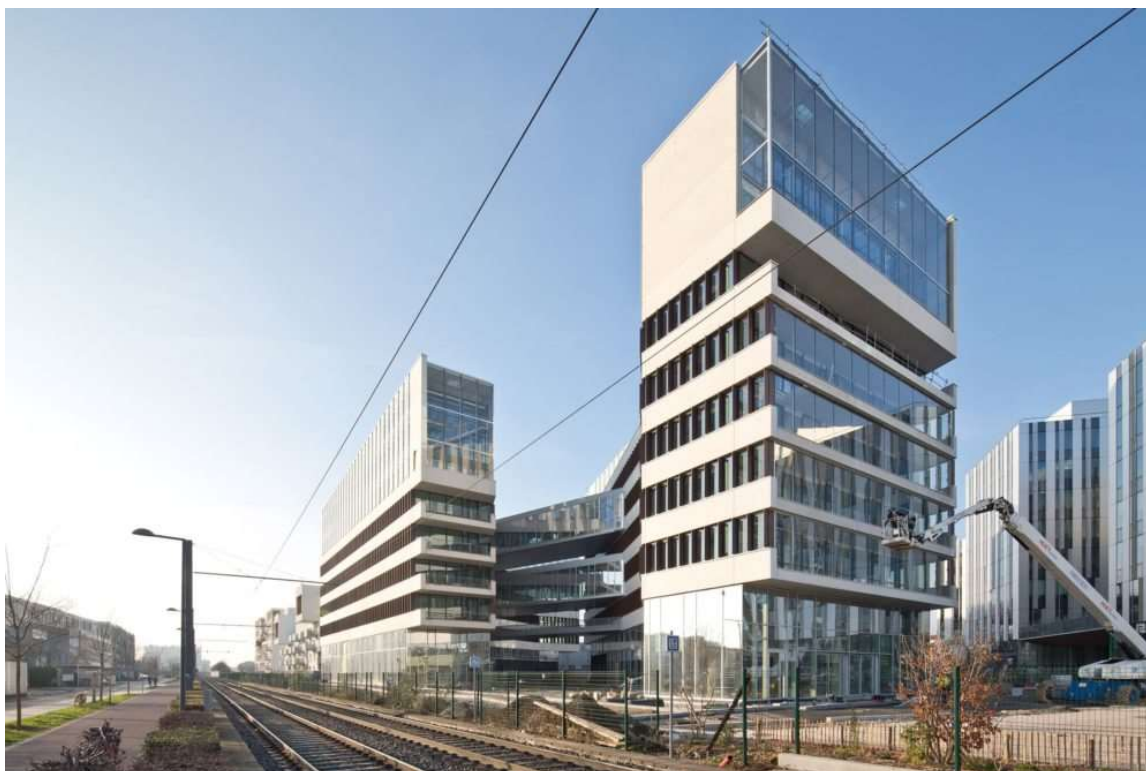
Figure3. 6 Organdi immeuble de bureaux. Source :(lefeuvre@effinergie.org, 2020b)
