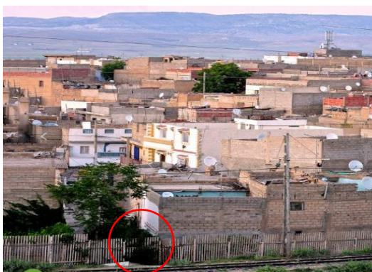
Figure 47 : Accès piétonne illicite. Source : Auteur, 2020.
