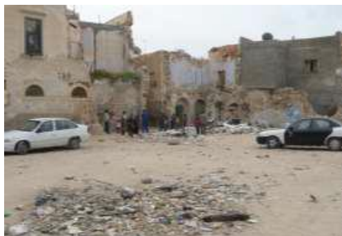
Figure 31 : Maisons démolies du quartier El Mina. Source : Dr. Isakha Diagana. 2010.
