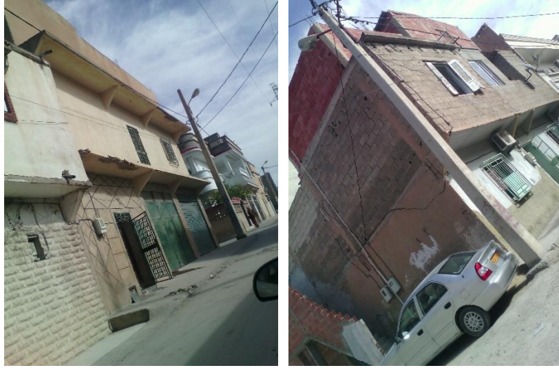
Figure 52 : Des habitations en dur, en R+1. Source : Auteur, 2020.
