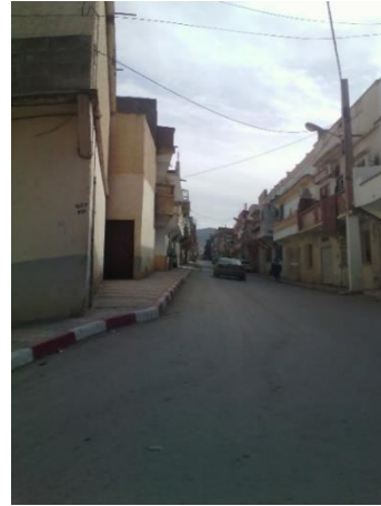
Figure 42: Voie secondaire dans le tissu. Source : Auteur, 2020.
