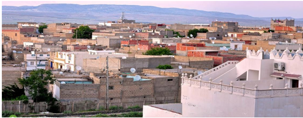
Figure 39 : Vue du quartier Draa El Imam.
