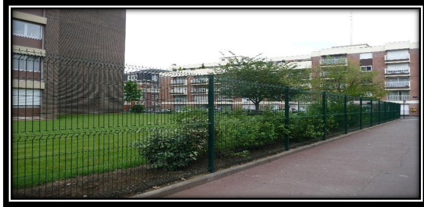
Figure 5: Espace vert d'accompagnement d'immeuble (privé) à Lille en France( pinterest.com/2019)
