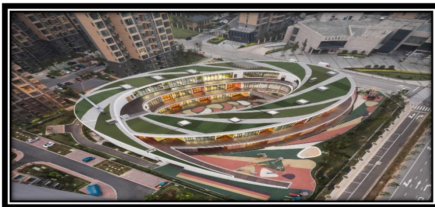
Figure 2 : Toiture végétalisée d'une Jardin d'enfant à WUXI en CHINE (Archidaily/2019)
