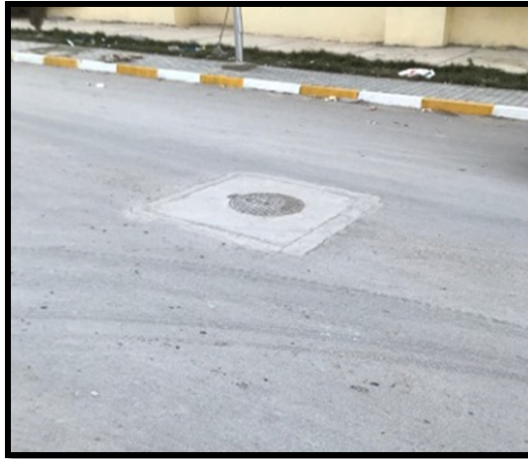
Image 43 : Regard d'assainissement du quartier 1000 logements social.
