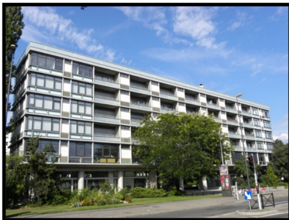
Image 22: Habitat collectif, immeuble écran. Source : site web : www.do-tours.com .
