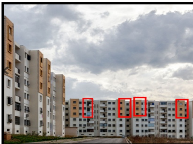
Image 47 : Le rythme de la façade du quartier de 176 logements Baba HACEN – Alger.
