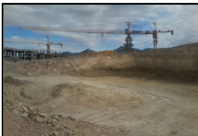
Image 35 : Les travaux de terrassement du quartier 1000 logements social. Source : OPGI de Tébessa, 2019.
