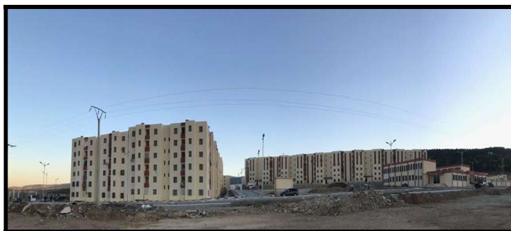
Image 44 : La façade urbaine du quartier 1000 logements social à pôle El Doukkane, ville de Tébessa. Source : Etudiante, 2019.
