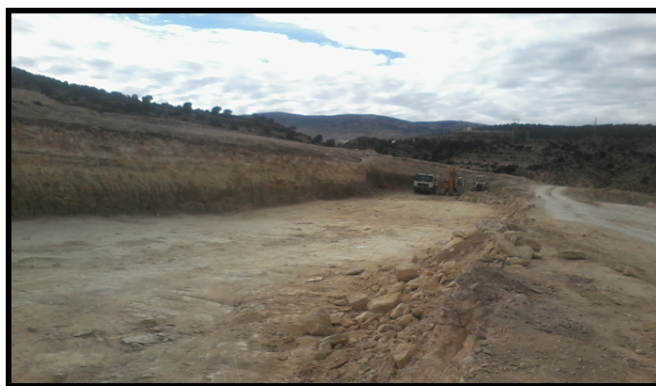
Image 34 : Les travaux de terrassement du quartier 1000 logements social. Source : OPGI de Tébessa, 2019.
