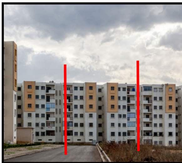
Image 48 : La symétrie de la façade du quartier de 176 logements Baba HACEN – Alger.
