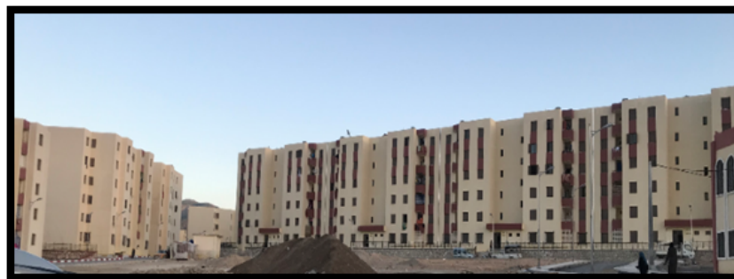
Image 45 : La façade du quartier 1000 logements social à pôle El Doukkane, ville de Tébessa. (Texture et couleur). Source : Etudiante, 2019.
