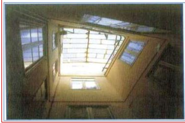
شكل: 51 فتحة في السطح فوق الفناء المصدر livre Ventilation et lumière naturel
