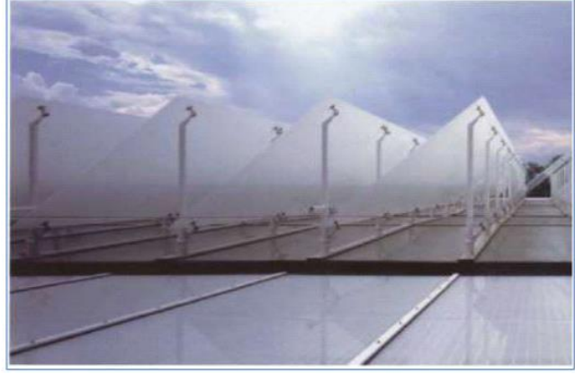
شكل 53: الحماية من اشعة الشمس عن طريق شرائح
