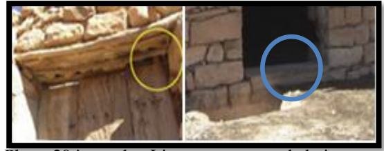
Photo 29 à gauche: Linteau en troncs de bois.
