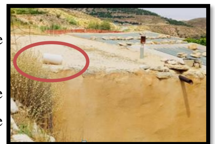
Photo 87: rouleau de compactage en pierre pour les toitures terrasses. Source: auteur
