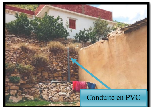
Photo 58. Conduite d'assainissement apparente. Source: auteur
