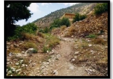
Photo 62. Dégradation des Clôtures. Source: auteur
