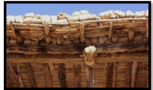
Photo26: Plancher terrasse avec une protection périphérique en pierres. Source: idem
