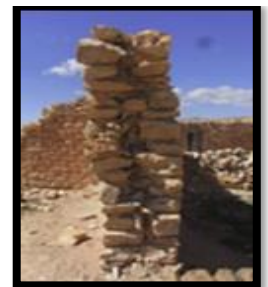
Photo 25: Mur en double rangée de Pierres intercalées de pierraille. Source: idem
