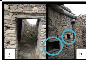
Photo 92 (a): linteau en bois plus arc. Photo 93 (b): linteau en bois sur la porte et linteaux en pierre sur les fenêtres. Photo 94 (c): seuil en pierre taillée. Photo 95 (d): seuil en pierres fixées au sol. Source: auteur (2019).
