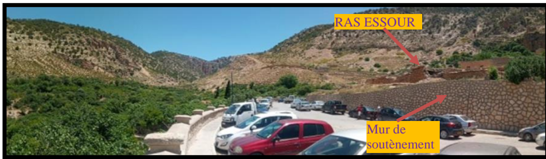
Photo 78: Vue sur le côté Est de Ras Essour depuis le chemin vicinal et le parking. Source: auteur
