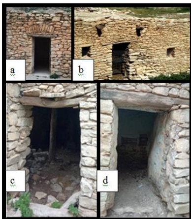
Photo 92 (a): linteau en bois plus arc. Photo 93 (b): linteau en bois sur la porte et linteaux en pierre sur les fenêtres. Photo 94 (c): seuil en pierre taillée. Photo 95 (d): seuil en pierres fixées au sol. Source: auteur (2019).
