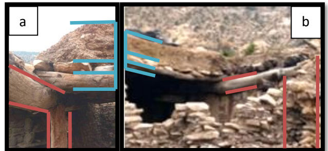
Photo 85 (a) & Photo 86 (b): Un effondrement partiel du toit révèle ses composants et le cadre qui le supporte. Source: auteur
