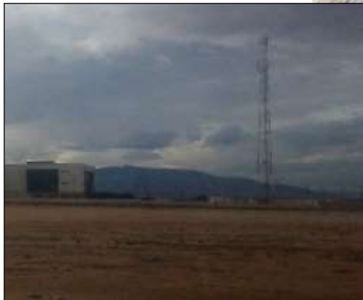
الصورة 14: أعمدة كهربائية
