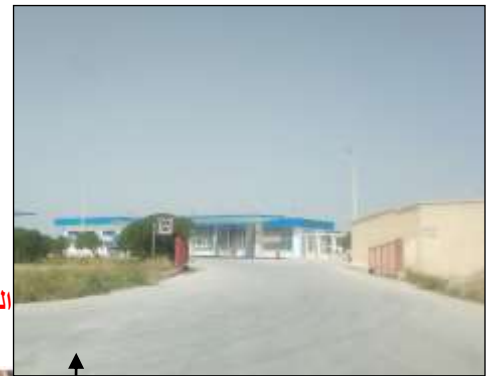
الصورة 12: محطة الخدمات
