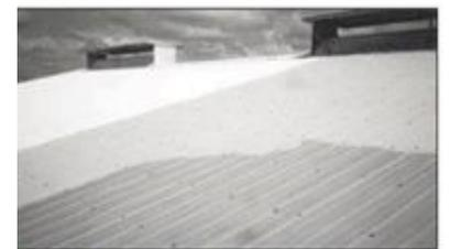
Figure 08 Enduit réfléchissant appliqué sur un toit source (Deny & Gaumont, 2008)
