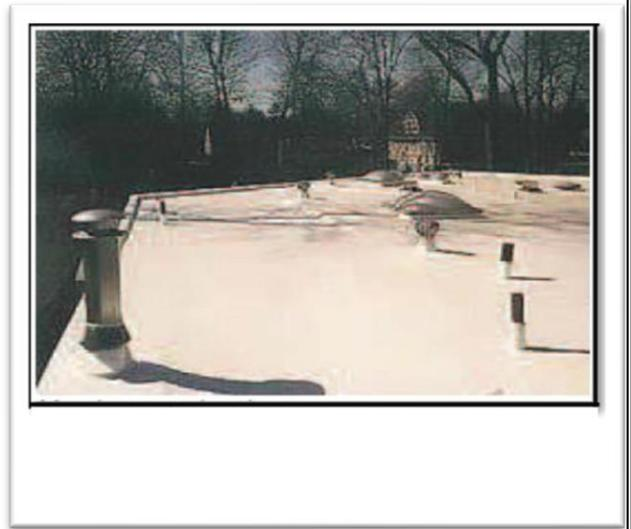
Figure 07 Membrane polyurée source (Deny & Gaumont, 2008)
