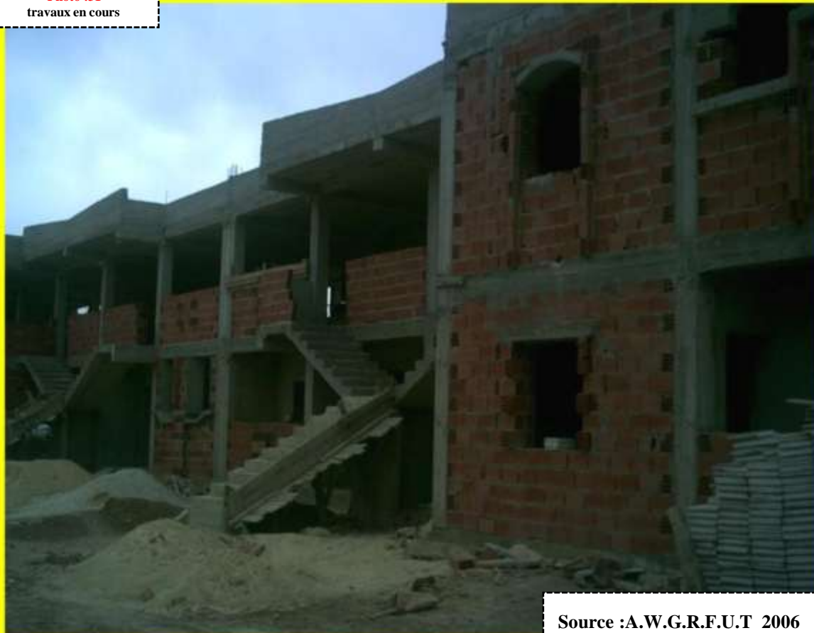
Photo :31 travaux en cours
