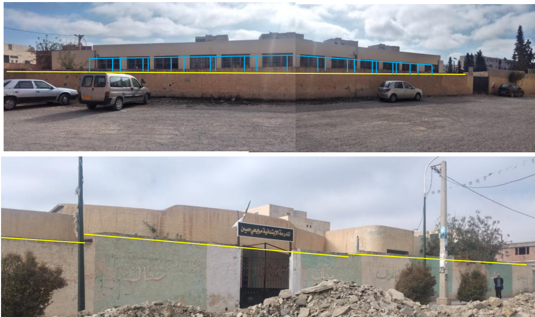
Fig N° 44: Façades de l'école de la MRAIHI HOUSSINE Source: Auteur 2022
