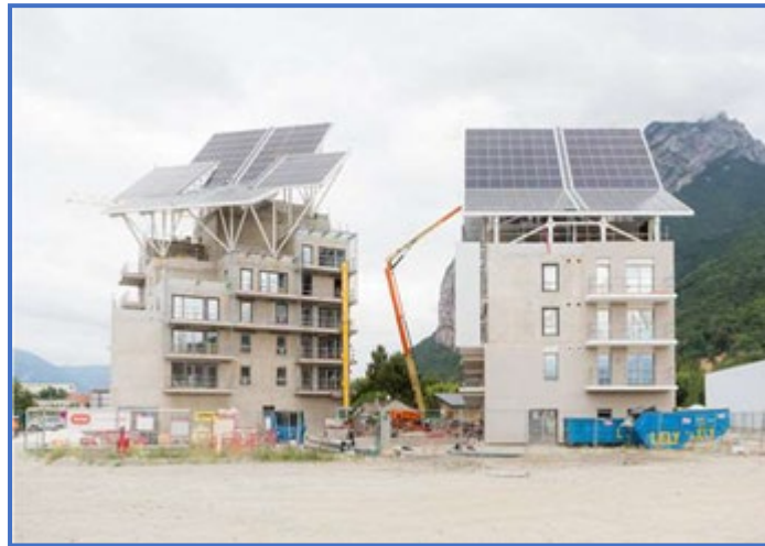
Figurel. 4 : photo représente un concentré de technologies pour un bâtiment autonome. Source :(Le Moniteur 2020)
