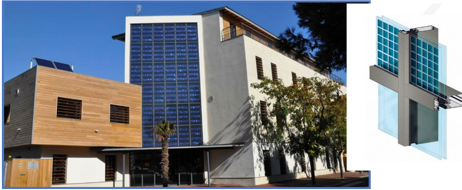
Figure 1.26 : Mur rideau photovoltaïque.
