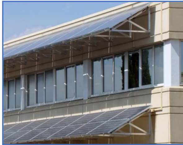
Figure1.24 : brise de soleil photovoltaïque. Source : (neonext.fr 2022)
