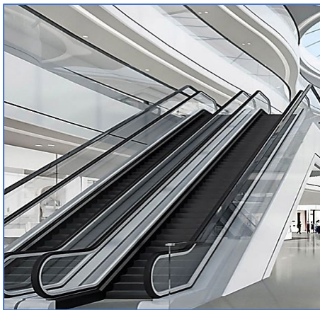
Figure 2.23 : circulation assurée par l'escalator
