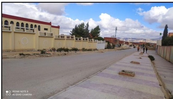
Photo 11: Voie en bonne état.
