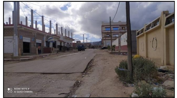
Photo 10: Voie en mauvaise état.
