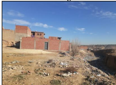
Photo 3: Logement dans la zone de servitude d'Oued Nagues
