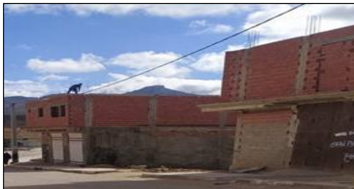
Photo 14 : Les façades des logements informels en dur.
