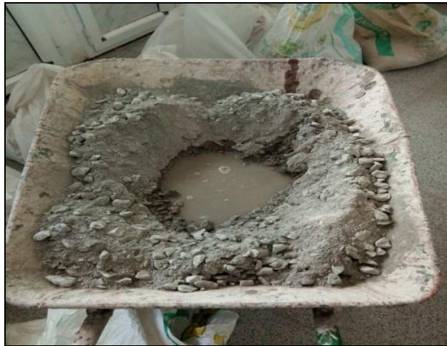
Photo V.12 Préparation de béton
