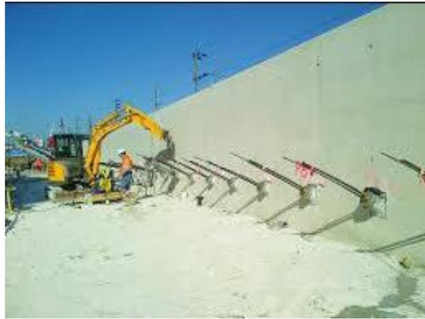
**Figure.II.22** : image de la mise en place d'ancrage
