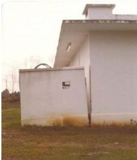
Figure 2.31 Tassement différentiel Du terrain sous les fondations Ismail, (Meknès))
