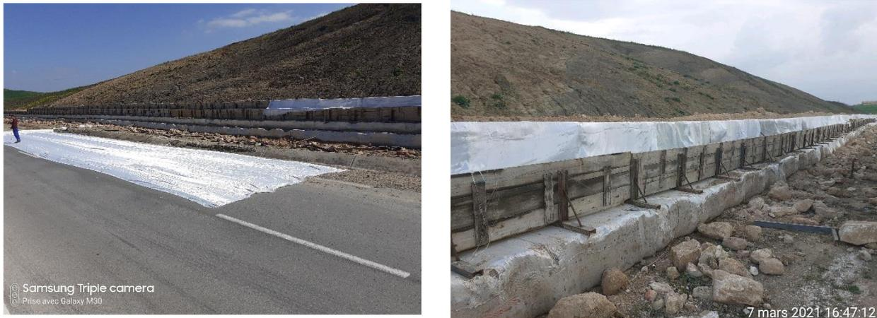
**Figure 2.3 :** Utilisation du géotextile dans le renforcement
