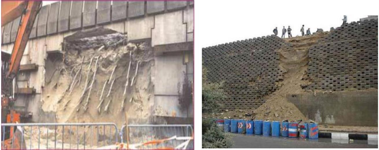
**Figure 2.21** : Rupture brutale d'un ouvrage sans signes précurseurs, et un mur en terre armée (présence d'une nappe d'eaux). [25]
