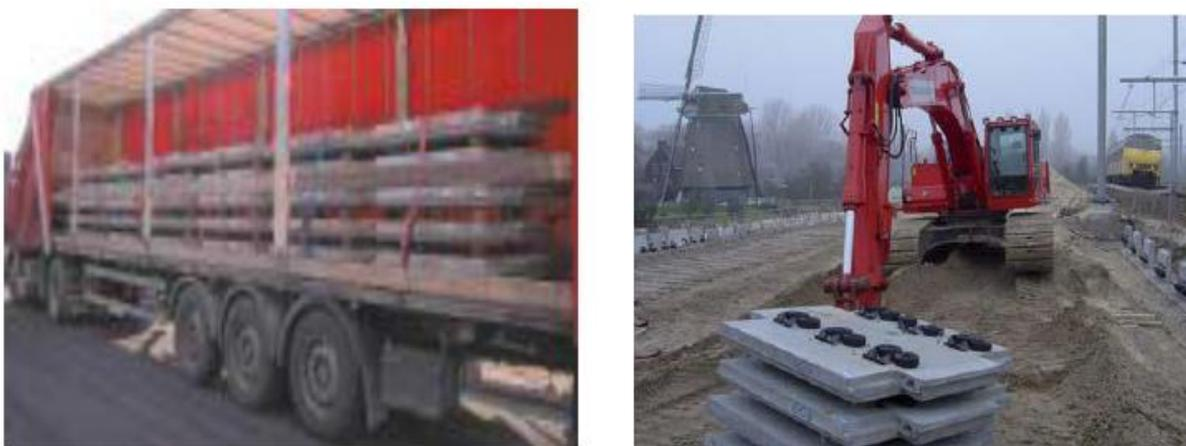
**Figure 2.12** : Stockage et déchargement des panneaux [7]
