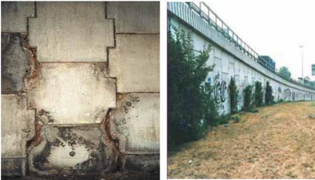
**Figure 2.22** : Dégradation du béton d'une écaille par réaction sulfatique externe et défaut d'entretien. [25]
