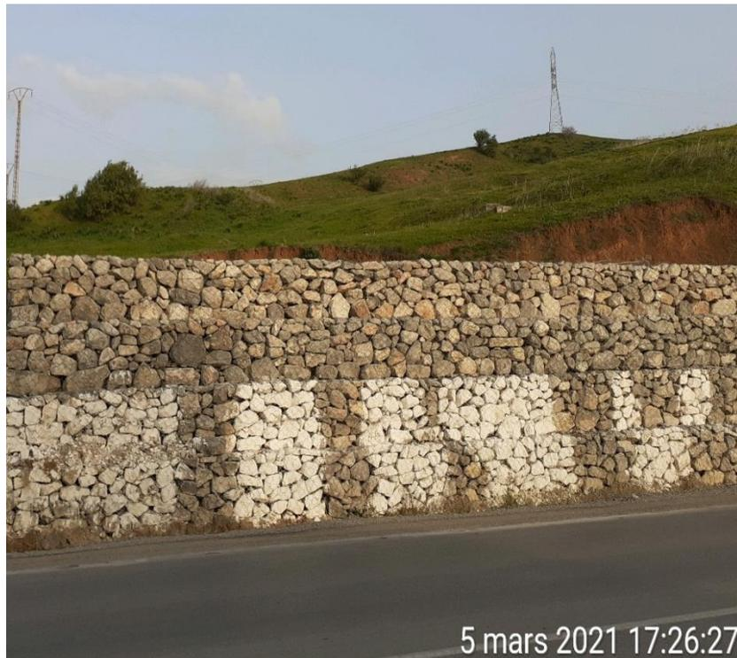
**Figure 1.2 :** Mur en gabion
