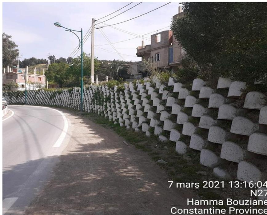
**Figure 1.3 :** Mur en sol renforcé (terre armé)
