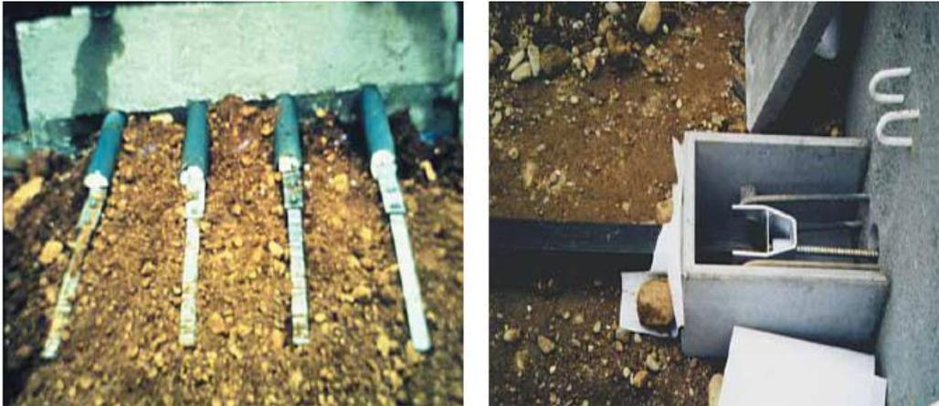
**Figure 2.19 :** Pose des témoins de durabilité, renforcements métalliques et géosynthétiques.
