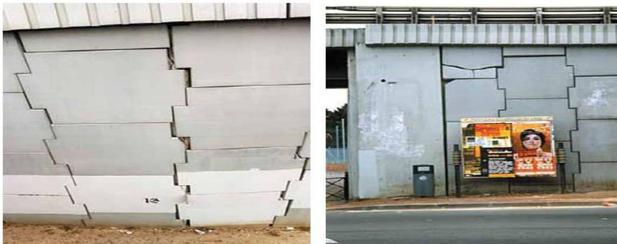
**Figure 2.20 :** Mouvement d'écaillés dus à un tassement différentiel, sans et avec fracturation du parement. [12]
