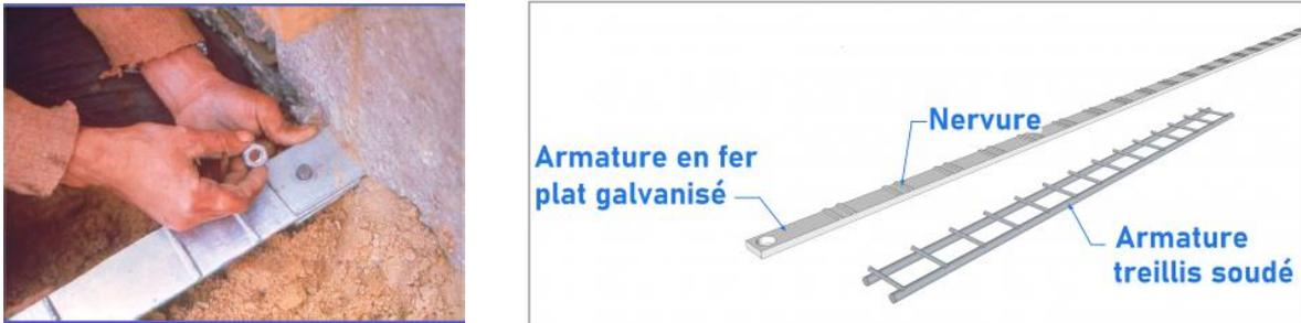
**Figure 2.5 :** Armatures de renforcement métalliques. [30] et [29]
