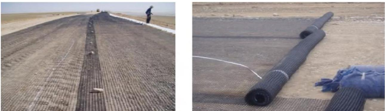
**Figure 2.4 :** Utilisation du géogrille dans le renforcement [16]
