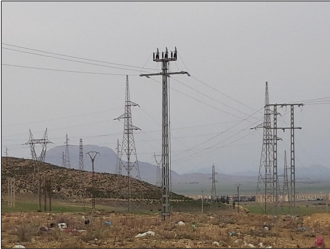
Figure 5.1 : obstacles constatés sur le site d'étude, réseau hydrographique et lignes électriques de haute tension
