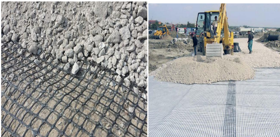
Figure 4.5: renforcement par geogrilles
