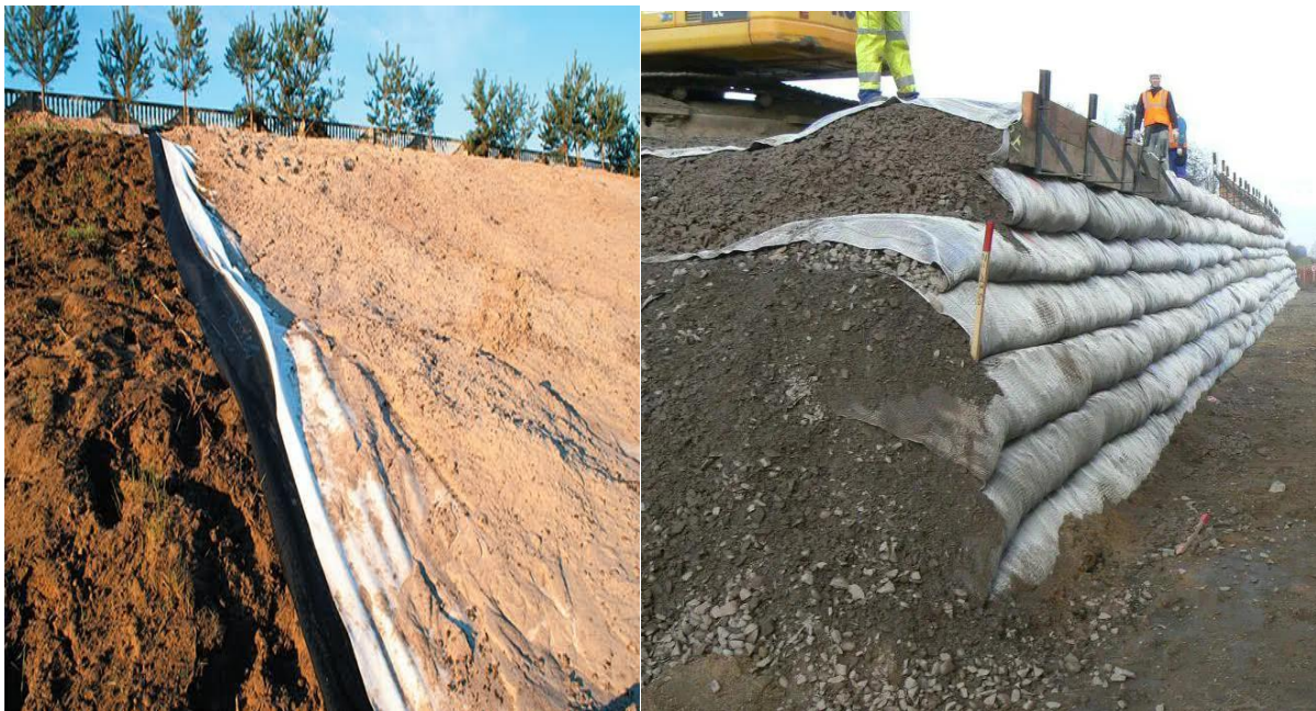
Figure 4.4 : renforcement de sol par géotextiles
