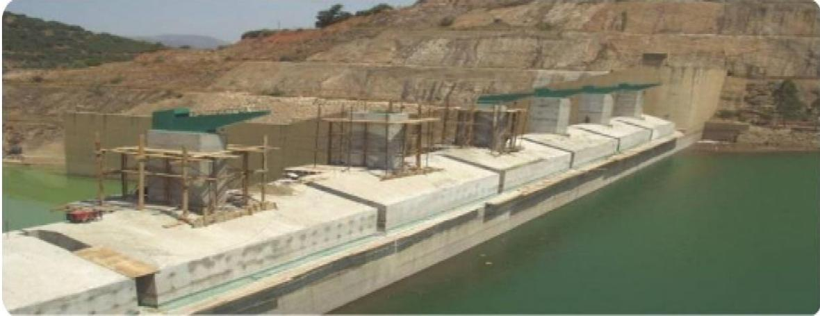
**Figure 2.15-**Méthode de surélévation des barrages.
