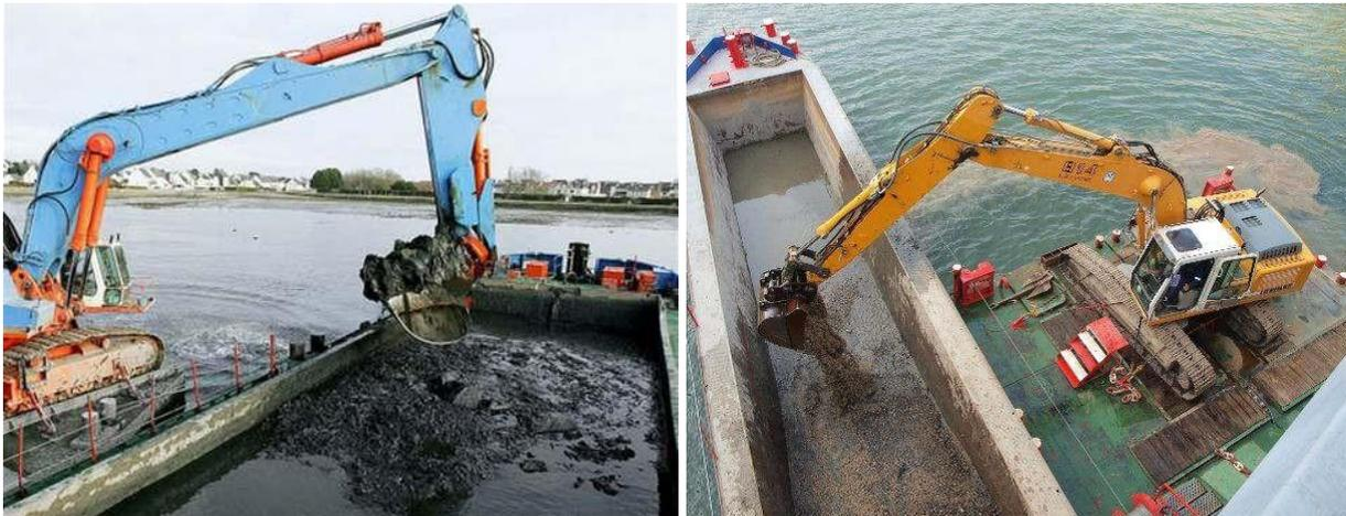
Figure 2.10-Dragage mécanique.
