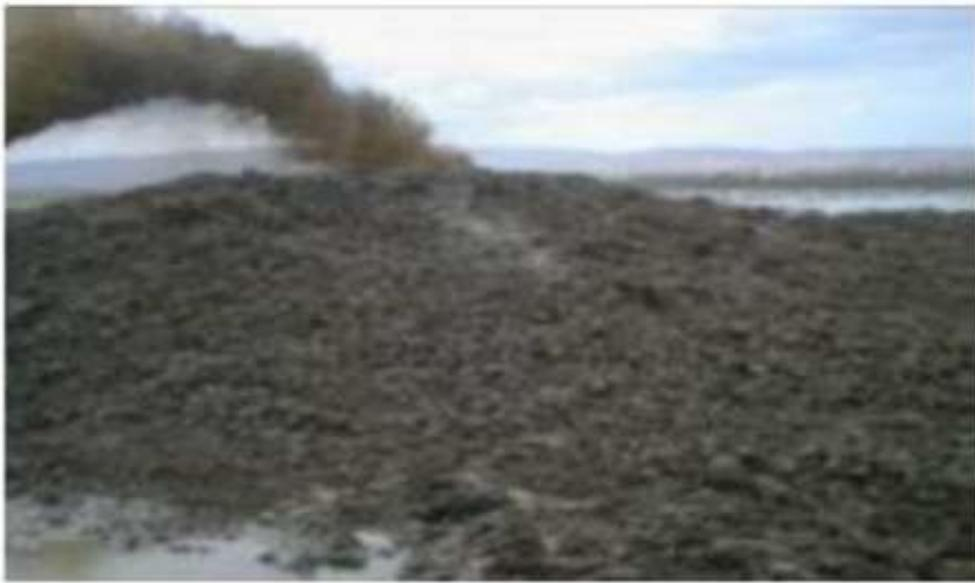
**Figure 2.12-**Rejet de la vase draguée (Barrage de Fergoug).
