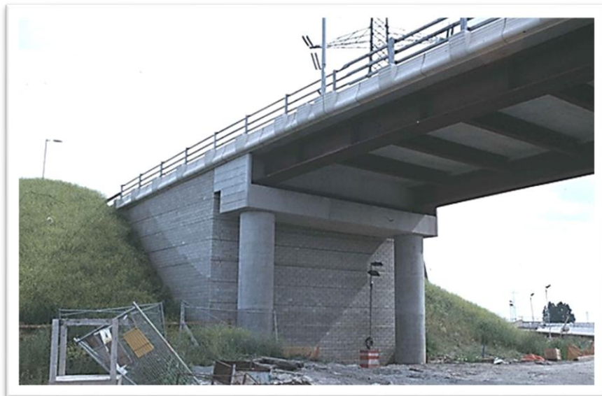
Figure 2.9 Culée de pont [9]
