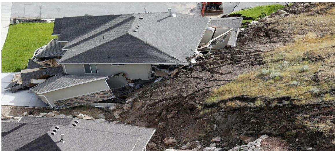
Figure 1.8 Rupture rotationnelle sans fissuration du remblai (glissement) [23]
