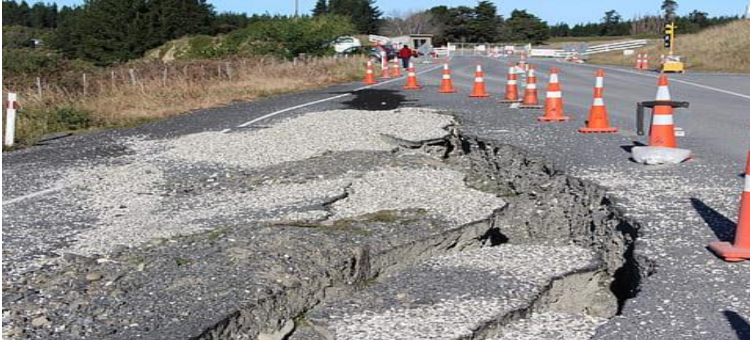
Figure 1.9 Rupture rotationnelle avec fissuration du remblai [28]
