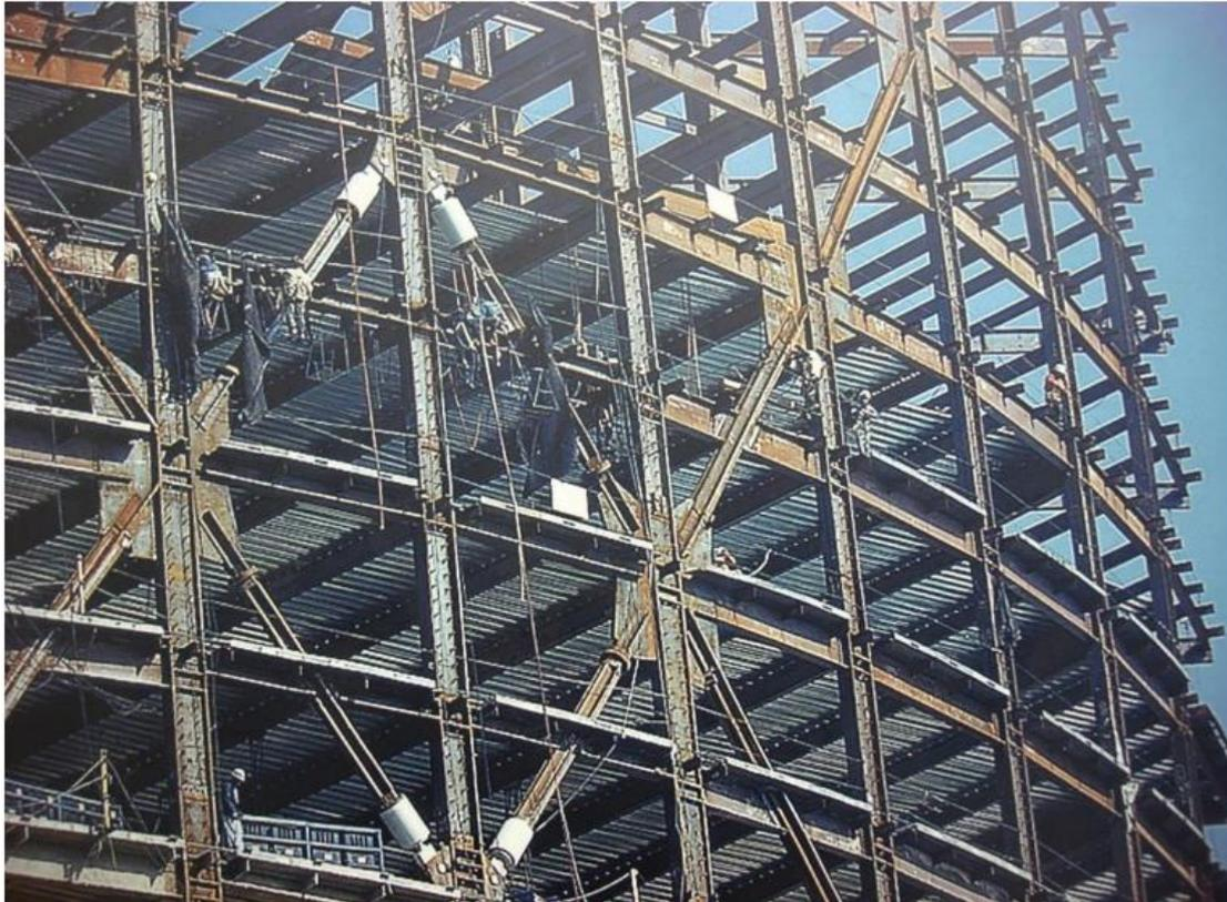
**Figure 2.6 :** Amortisseurs dans les cadres Mega-Brace
