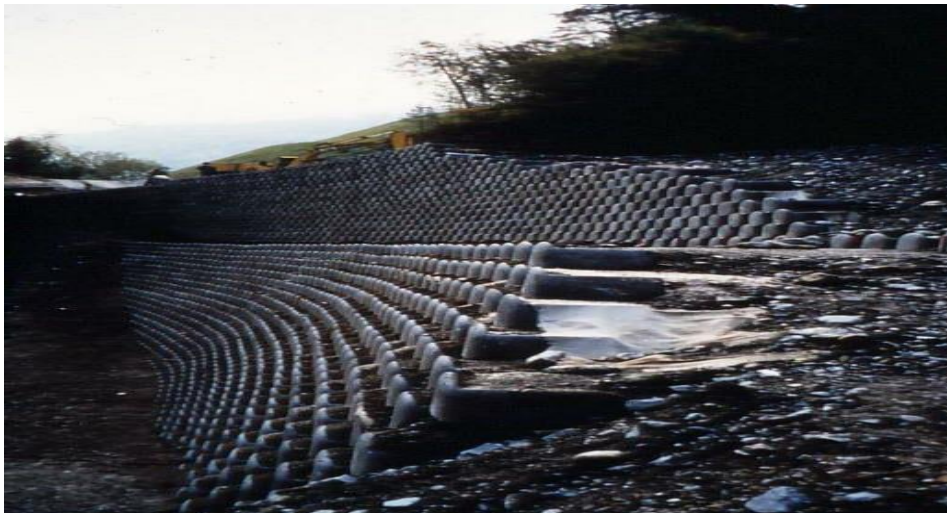
Figure 2-8 Mur Massifs en sol renforcé
