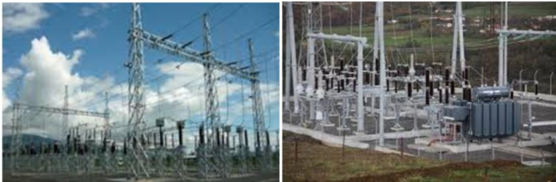
Figure I.5 Poste classique extérieur.
