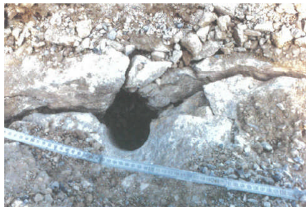
Figure 5 Découpage vu en surface. La mise à feu d'un explosif approprié à l'intérieur de plusieurs trous rapproché et coplanaires permet d'obtenir une fissure de découpage.
