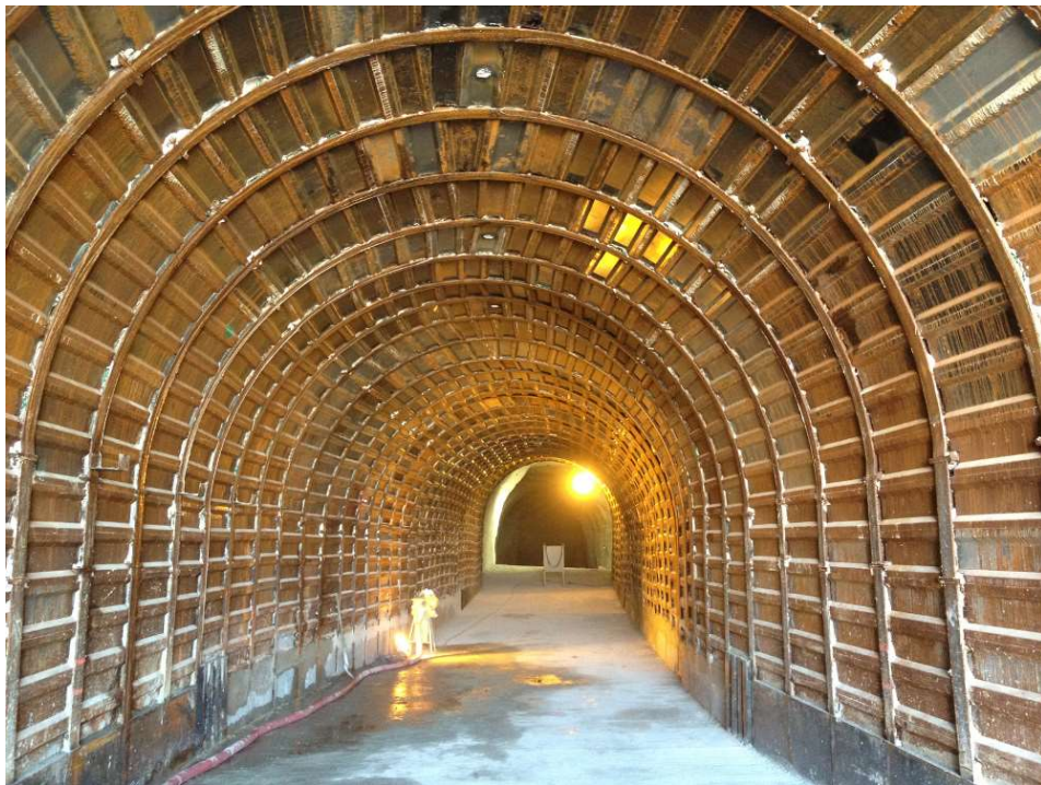
Figure 4.13. Soutènement par blindage.
