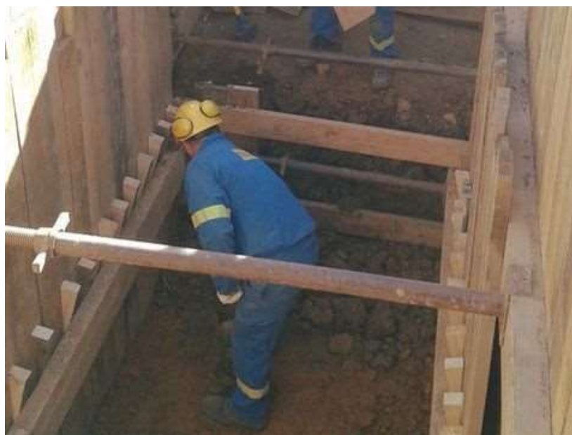
Figure 5.5. Platelage butonné.
