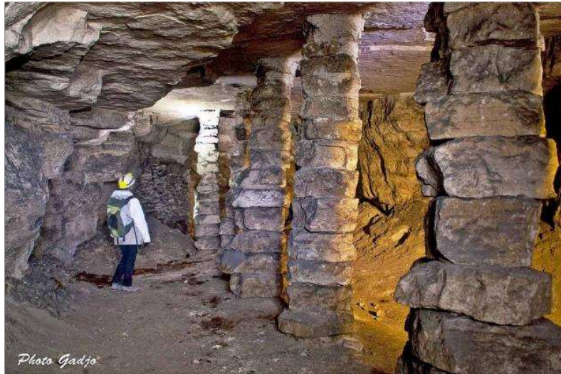
Figure 4.13. Soutènement par colonnes de pierres.
