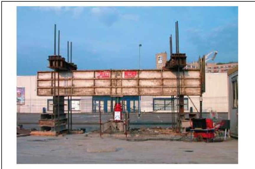
Fig. 5.7 Vue de l'essai de chargement en cours.
