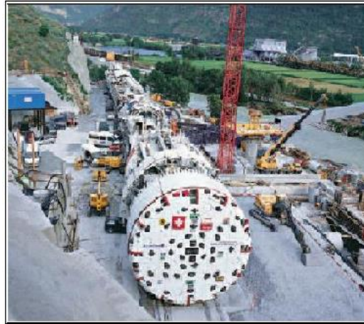
Figure.2.12. Tunnelier en mode fermé [14]
