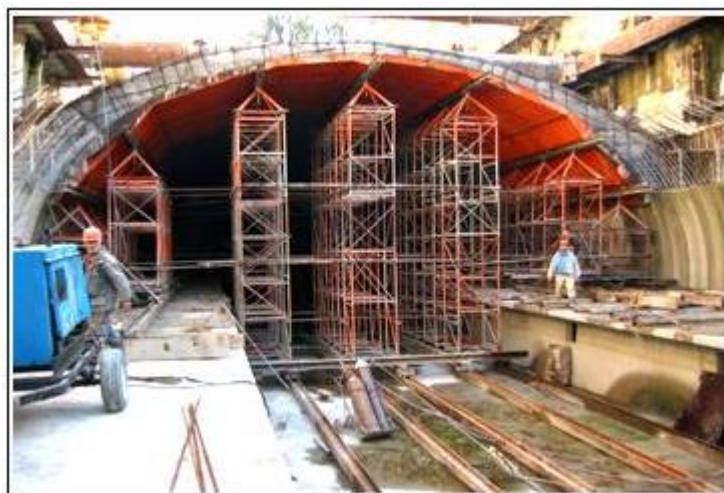
Figure.2.7. Station Hamma durant la phase de construction
