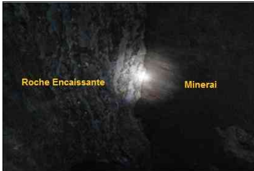
Fig. 7: Contacte Minerai/ Roches encaissante -3 ème phase-.
