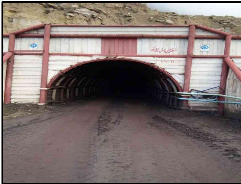
Fig. 13: Ouverture par galerie au jour, niveau 1105.
