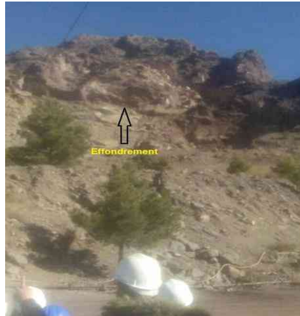
Fig. 10: Effondrement de la mine de Boukhadra au-dessus des étages exploités.
