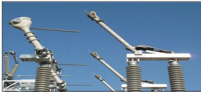
Figure 1.5: Sectionneur.
