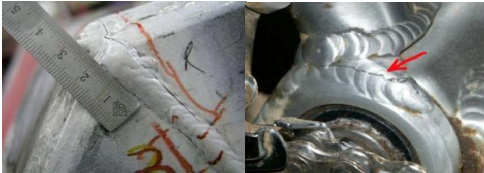
Figure.3.11 : Exemples de fissures sur aluminium [48]
