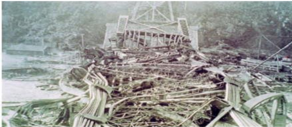
Figure1.3 - L'effondrement du pont du Québec 1907
