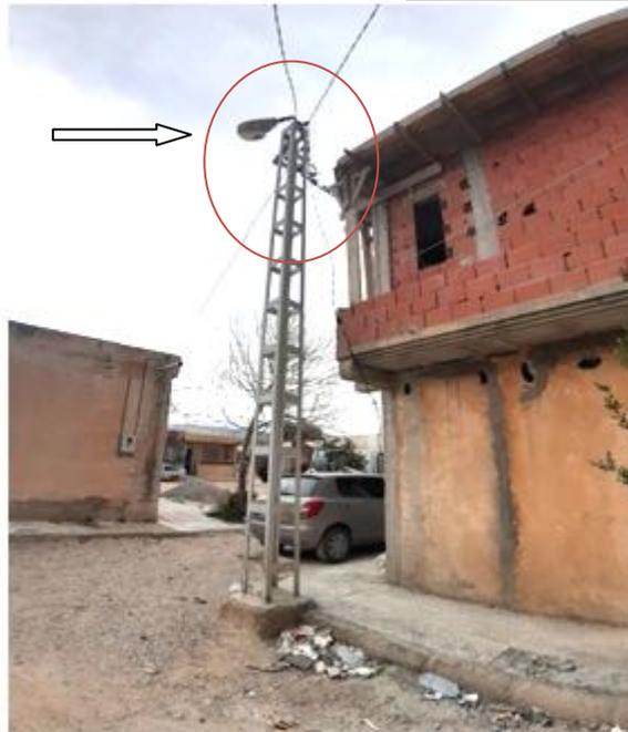
صورة تبين مدى ملاصقة البناء للعمود الكهربائي من التقاط الطالب 2021
