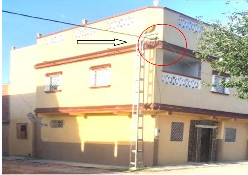
صورة تبين مدى ملاصقة البناء للعمود الكهربائي من التقاط الطالب 2021
