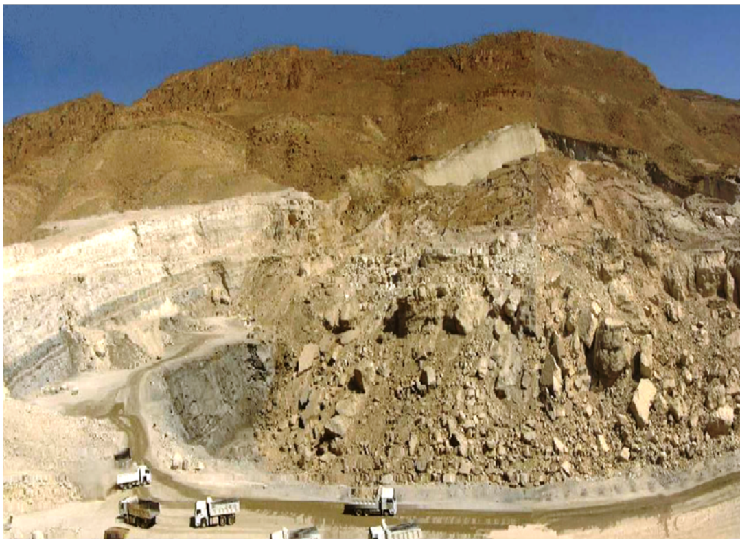
Figure 5.1 : glissement de kefessnoun
