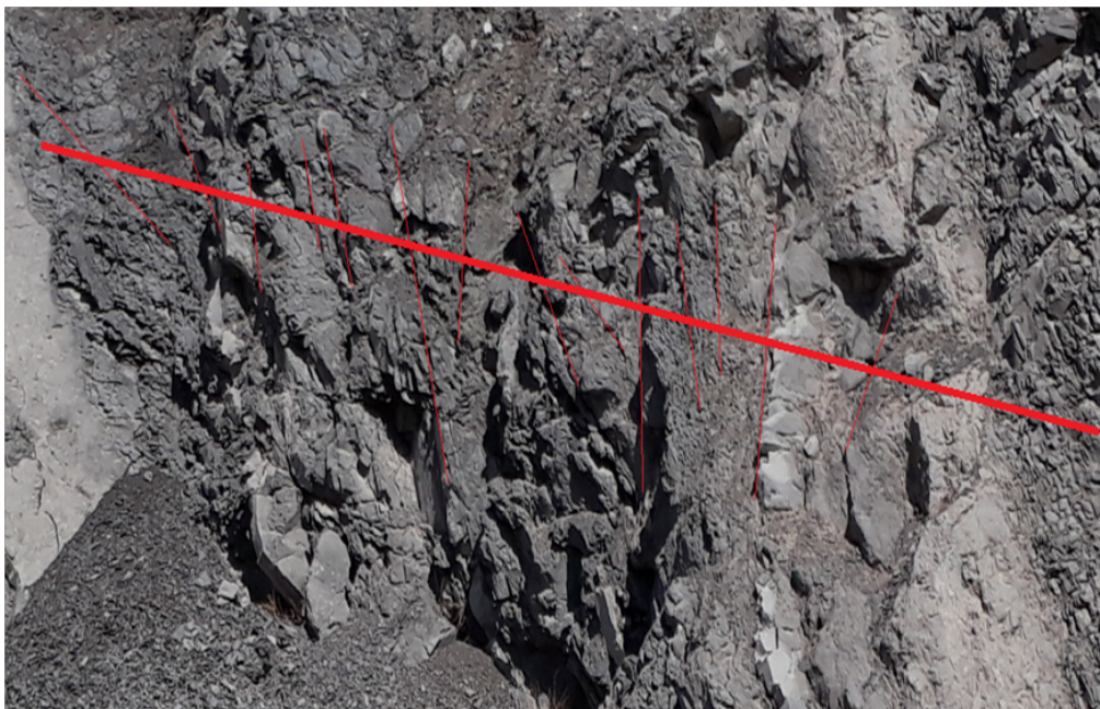
Figure 2 : mesure les discontinuités(Front de marne).
