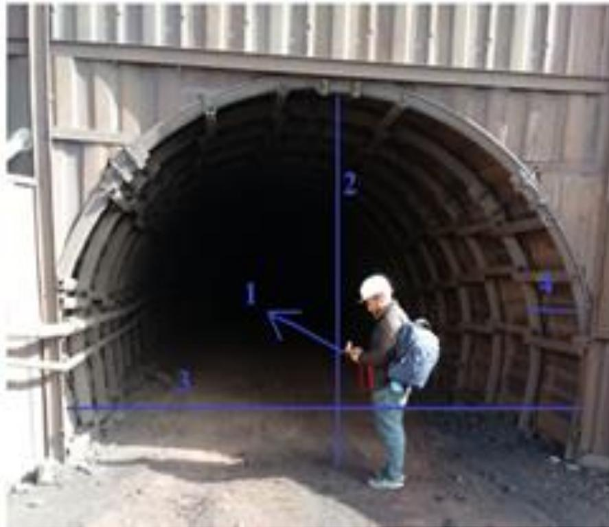
**Figure 5.9 :** Caractéristiques géométriques de la galerie de base du niveau 1105m ; (1) Orientation de la galerie ; (2) Hauteur de la galerie ; (3) largeur de la galerie ; (4) Espacement des cintres.
