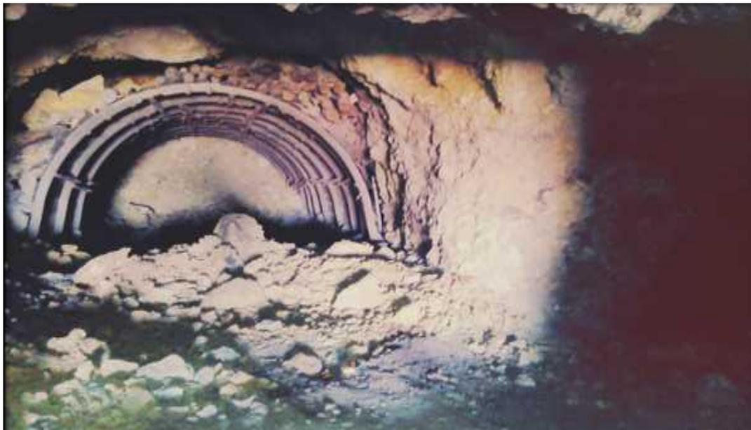
**Figure 5.14 :** Eboulement dans la galerie de la 4<sup>ème</sup> phase (niveau 1045m)
