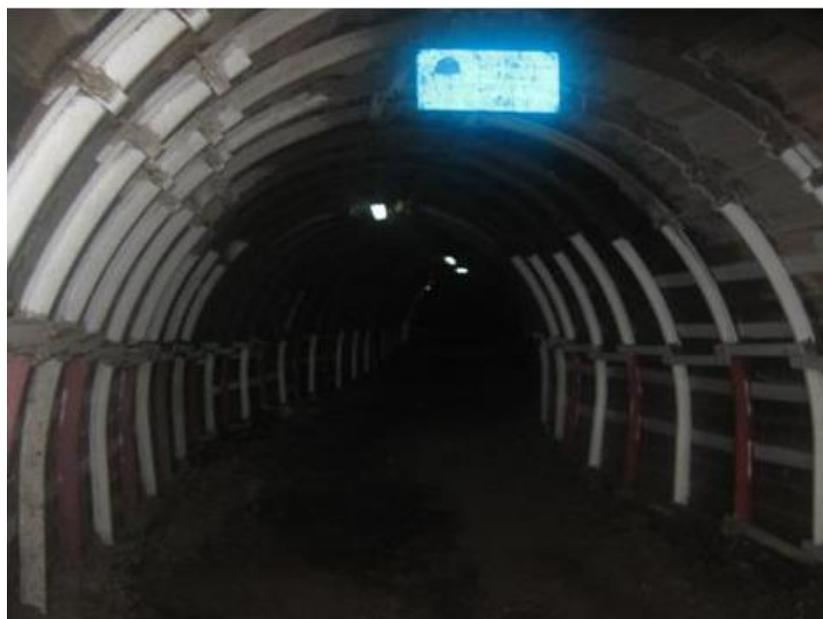
**Figure 1.2 :** Soutènement par cintres métalliques
