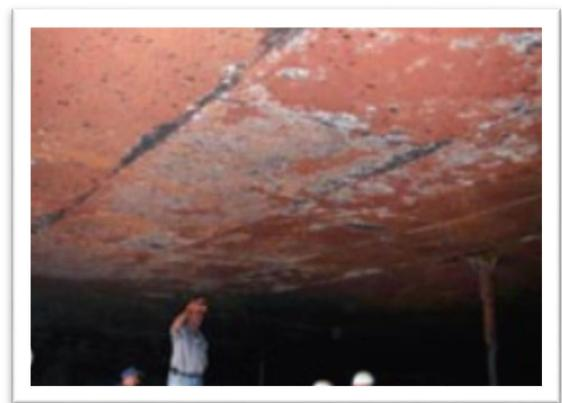
**Figure – I.2 : Corrosion généralisée**
