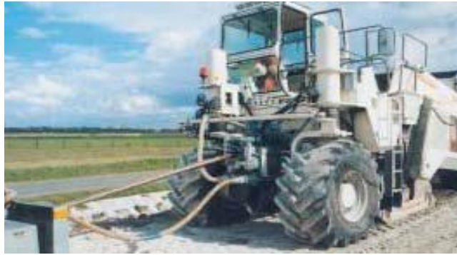
Figure32 : Appareil d'incorporation du ciment.
