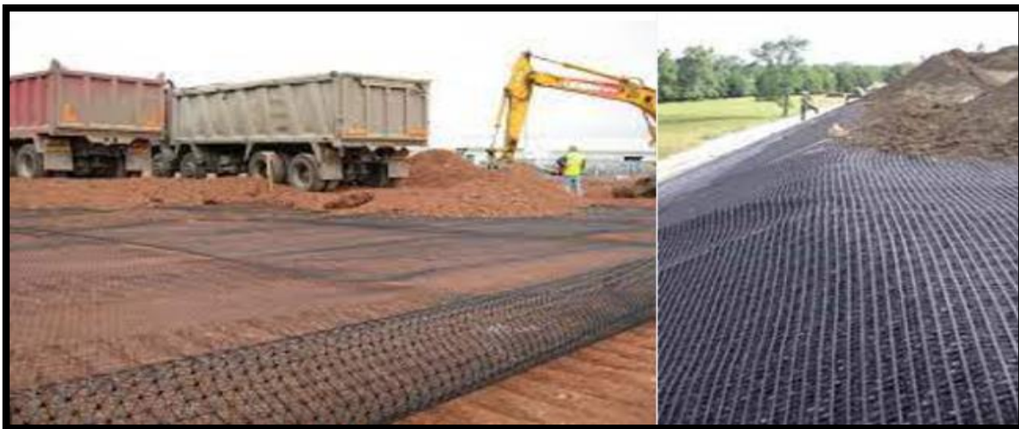
Figure 3.10 Géogrille de renforcement de sol.
