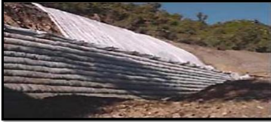
Figure 3.18 Vue de l'ouvrage (TIFRA).
