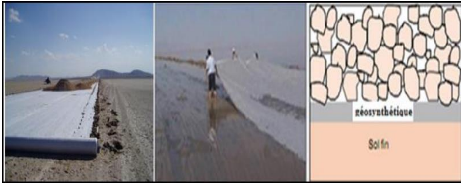
Figure 3.11 Séparation par géosynthétiques
