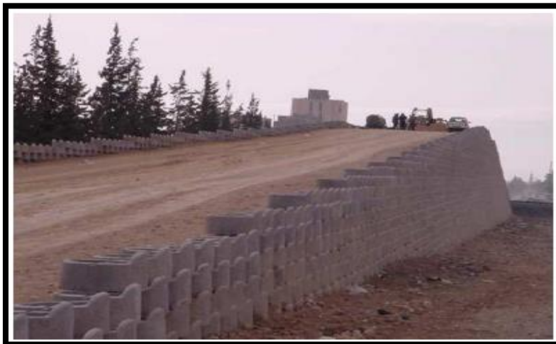
Figures 2.17 Vues de l'ouvrage en phase travaux
