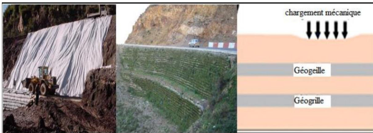
Figure 3.12 Traitement d'un Glissement de terrain Bejaia.
