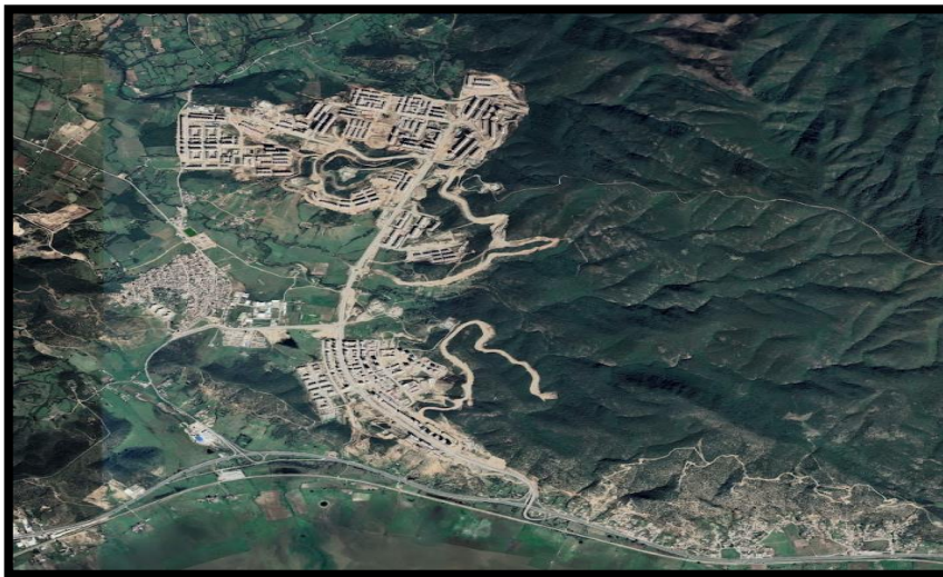
Figure 6.1 IMAGE AERIENNE LOCALISANT LE TERRAIN DEPROJET
