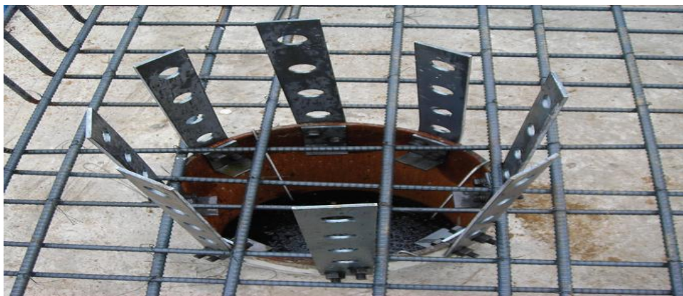
Figure 1. 14 Renforcement des têtes de pieux en acier à l'aide des connecteurs de cisaillement perforé .[19]
