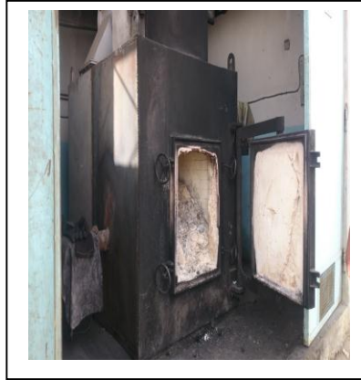
صور رقم ( 20 ، 21 ، 22 ): جهاز الترميد المزوج بمركز الردم التقني تبسة
