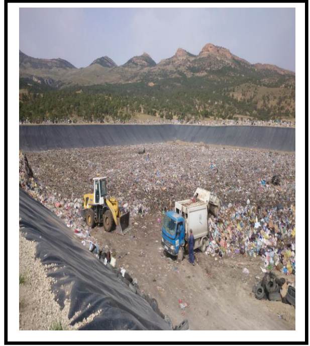
صورة رقم ( 12 ) : عملية دفن النفايات المنزلية بخندق الردم ، تاريخ التقاط الصورة : 12 افريل 2018
